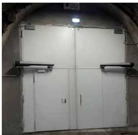
Esempio di installazione di 2 battenti antincendio di grandi dimensioni montate su portone antincendio installato in galleria
