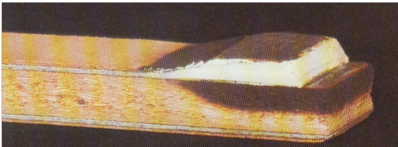
Le lastre isolanti termoespandenti possono essere utilizzate sotto spessori di MDF o impiallacciature per sigillare il perimetro della porta o del telaio senza avere guarnizione termoespandente a vista.
